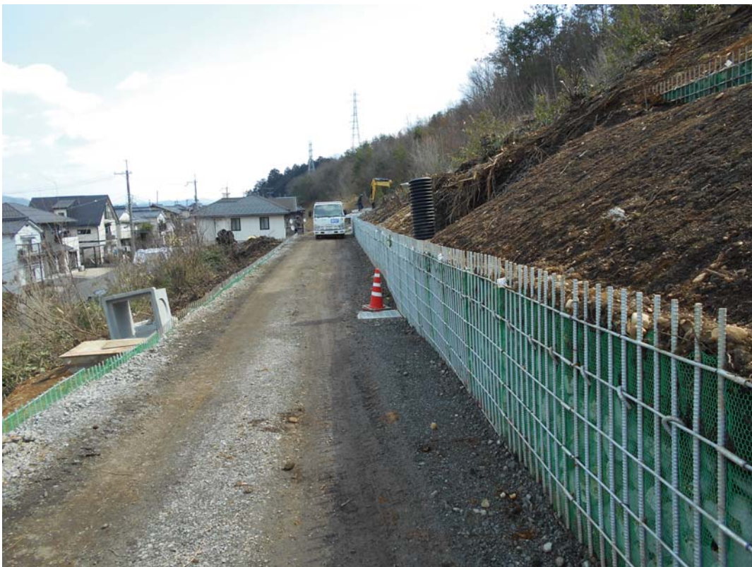
京都府福知山林道整備
