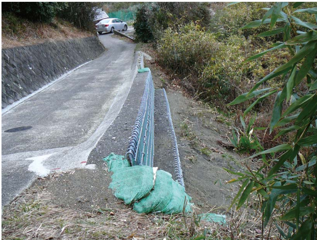
三重県名張市道路補修
