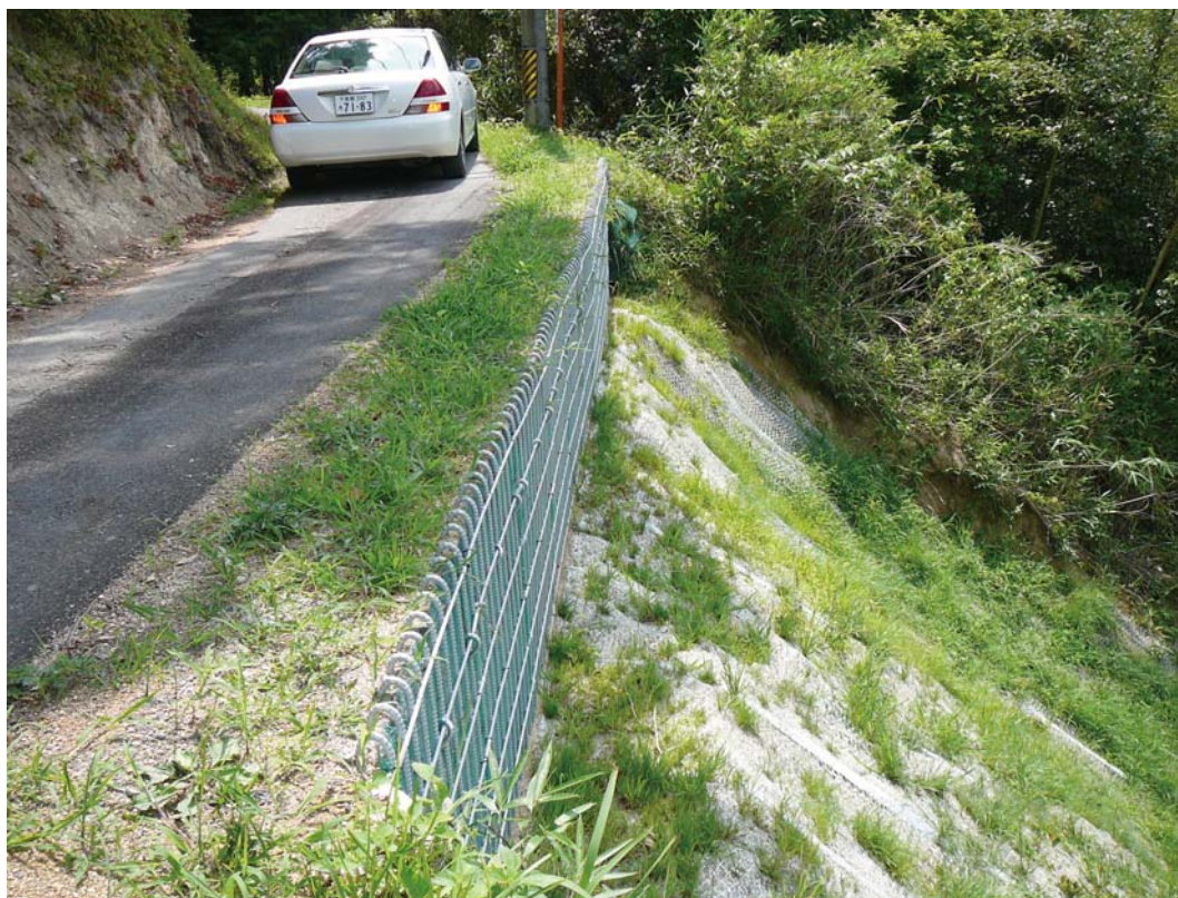
三重県伊賀市路肩補修
