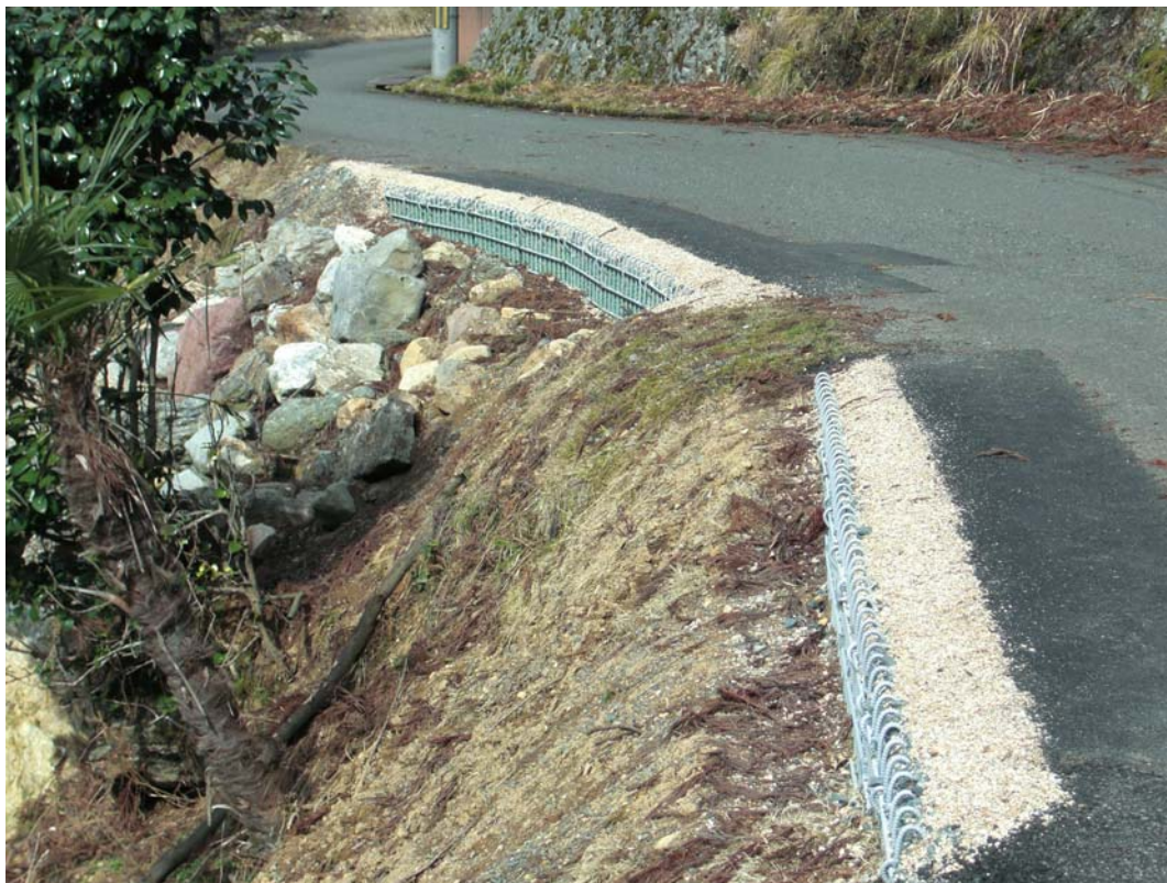
福井県小浜市路肩補修
