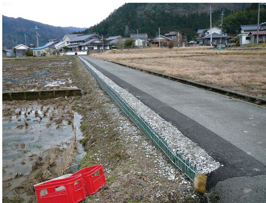
福井県小浜市道路補修
