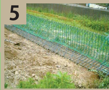
5 L型鉄筋を据付け
