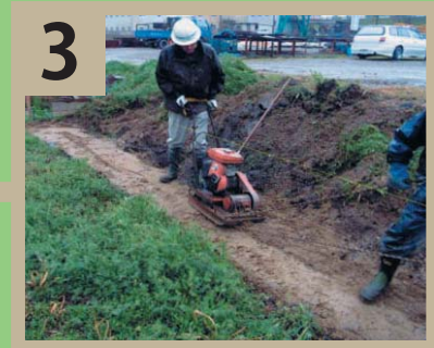
3 位置を決め掘削、整地
