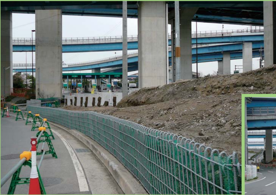
京都府 道路改築工事
