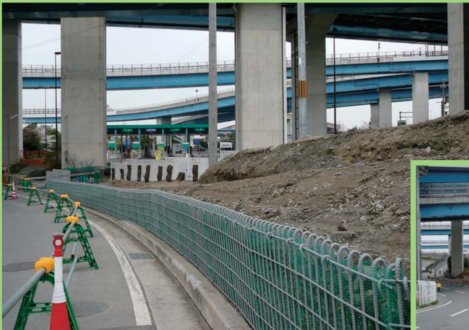
京都府 道路改築工事
