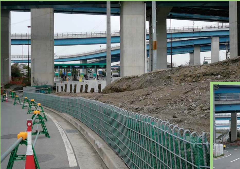
京都府 道路改築工事
